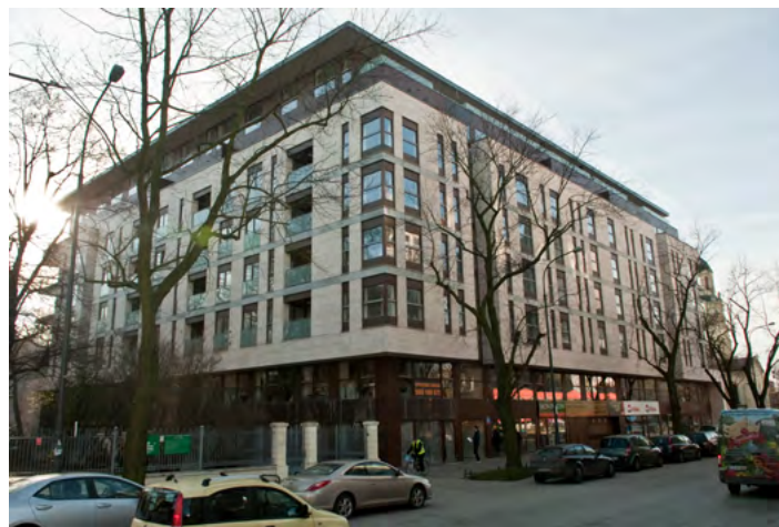
JK-3 - budynek Solaris Park, fot. - Rafał Józwiak.
